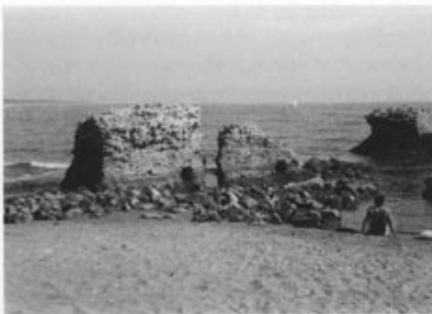
1 Pfeilerreste für eine Landungsbrücke im antiken Hafen Cosa/Italien. Die Pfeiler wurden ins Meerwasser betoniert (Bauzeit 2. Jahrh. v. Chr.).
