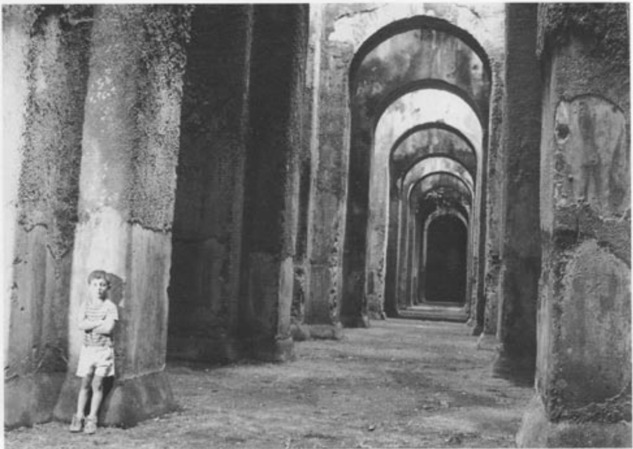
6 Zisterne Piscina Mirabilis bei Pozzuoli/Italien. Das 15 m tiefe Becken enthält 48 Pfeiler und eine Decke aus opus caementitium; es faßte 12 600 m 3 Trinkwasser (Bauzeit 1. Jahrh. v. Chr.)
