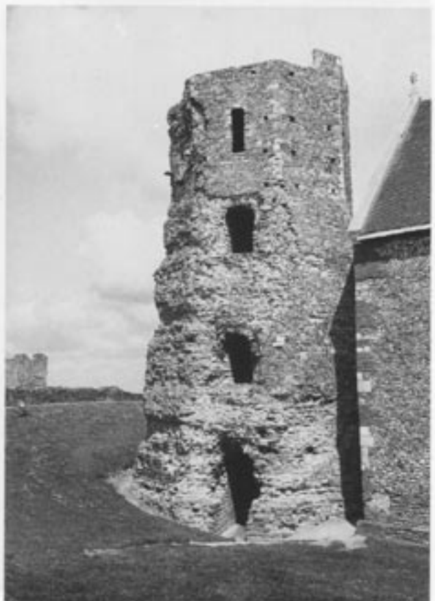
5 Leuchtturm aus opus caementitium an der Kanalküste in Dover/England (Bauzeit 1. Jahrh. n. Chr.)
