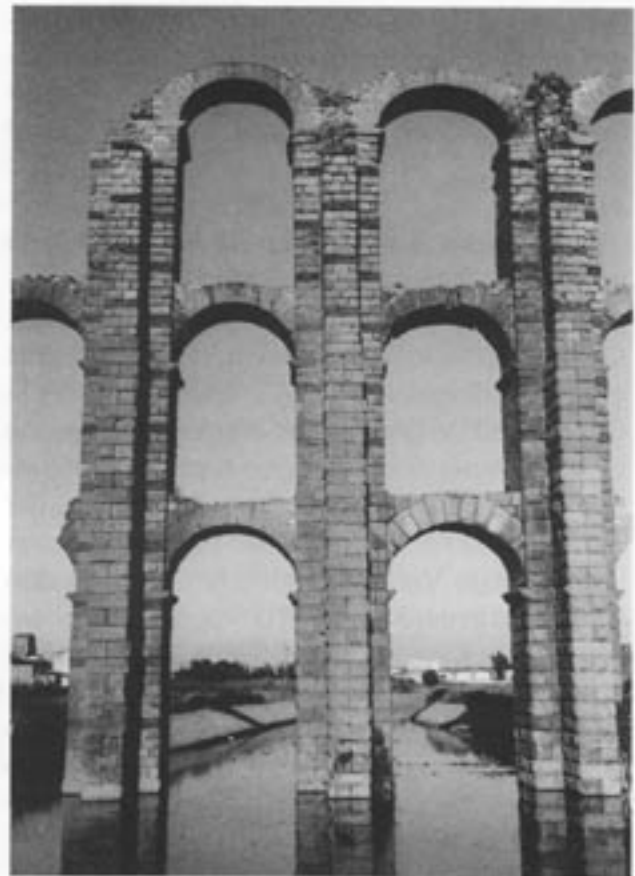
4 Reste des Aquädukts Los Milagros in Merida/Spanien. Er besteht aus Römischen Beton mit einer Schale aus behauenen Steinen (Bauzeit 1. Jahrh. n. Chr.)
